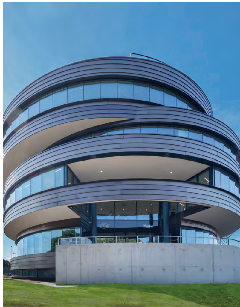
De detaillering van de gefelste gevelplaten is zeer nauwkeurig uitgewerkt, zeker waar de cirkels elkaar raken.
